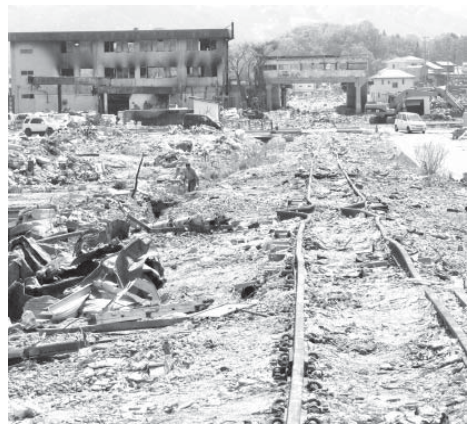
大震災の3ヵ月後、大津波の後に町中が火災に見舞われ、その高熱で曲がった陸中山田(岩手県)の線路の様子
