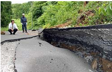
約10メートルにわたリアスファルトが陥没し、通行止めになった市道＝14日午後3時50分。 奥州市衣川区上立沢・黒滝温泉付近
