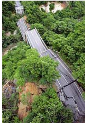
約10メートルにわたリアスファルトが陥没し、通行止めになった市道＝14日午後3時50分。 奥州市衣川区上立沢・黒滝温泉付近
